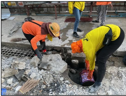
ภาพที่ 41 ขุดลอกท่อระบายน้ำ
